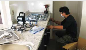
キッチン撤去作業
